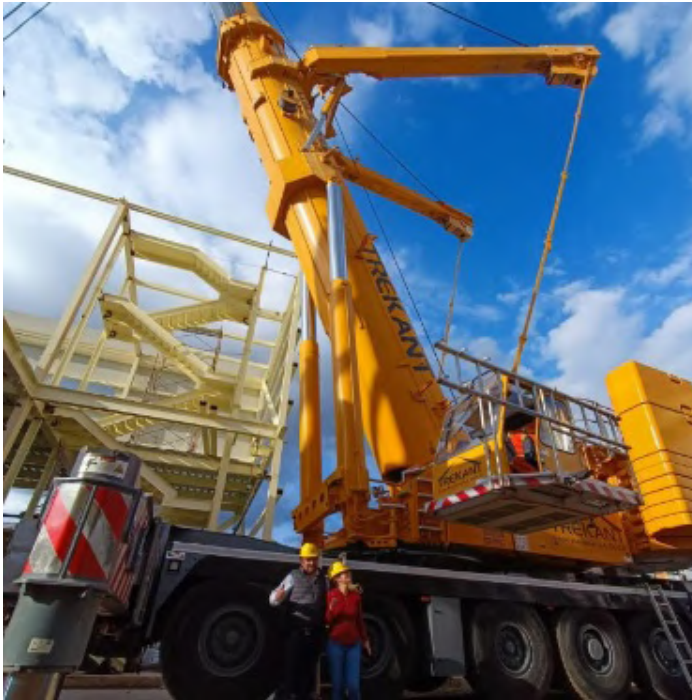
Figura 2. Grúa de 500 toneladas para la instalación
